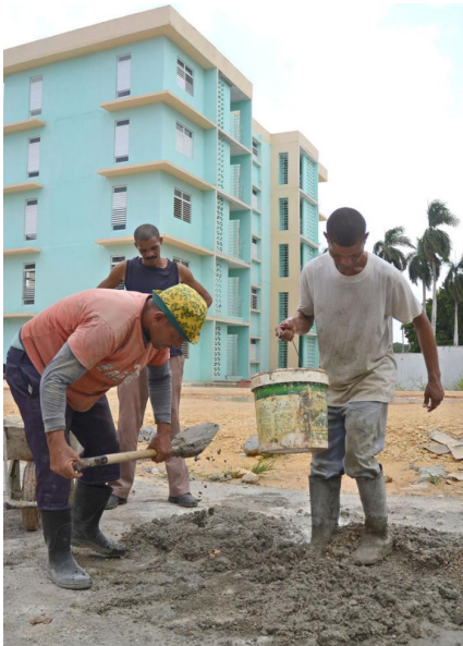
Bauarbeiter aus neun Provinzen sind an dem Projekt beteiligt (Quelle: Granma )
