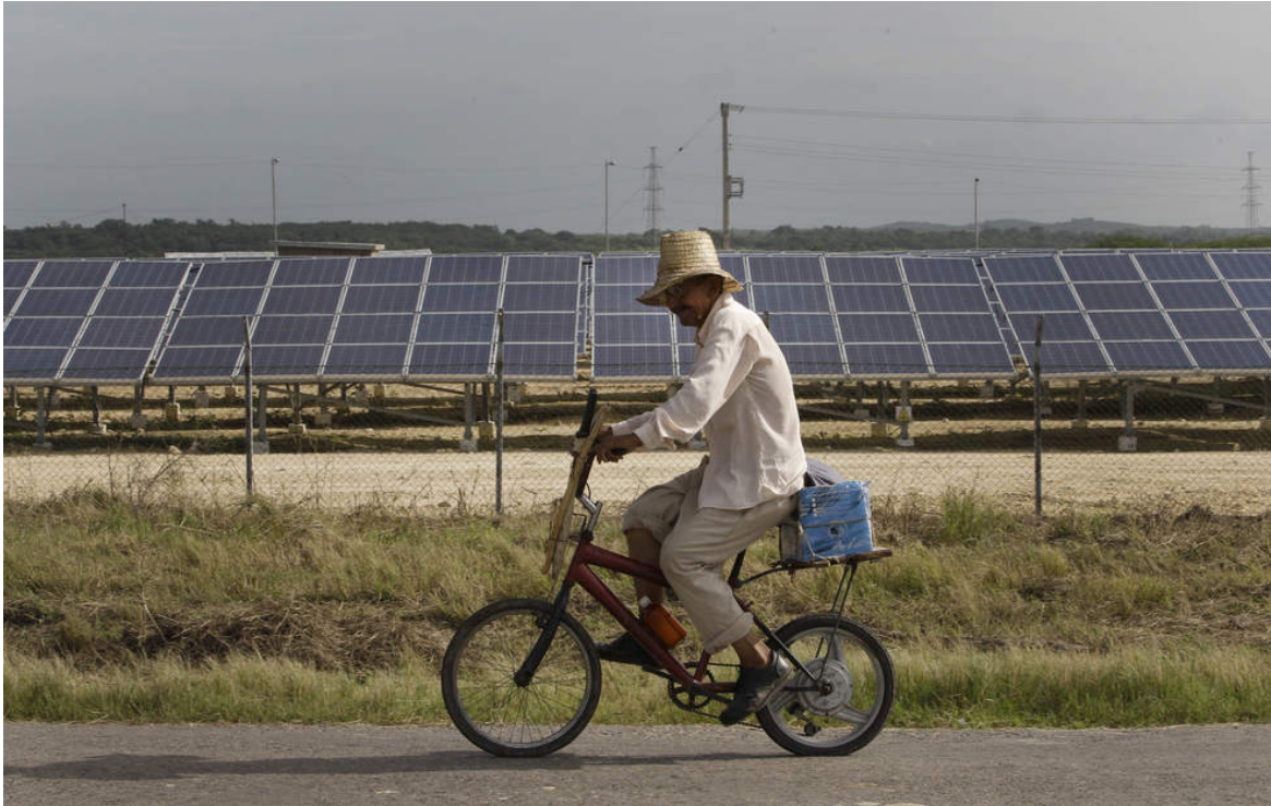
Der erste kubanische Solarpark ging 2013 in Betrieb (Quelle: Cuba Contemporanea )
