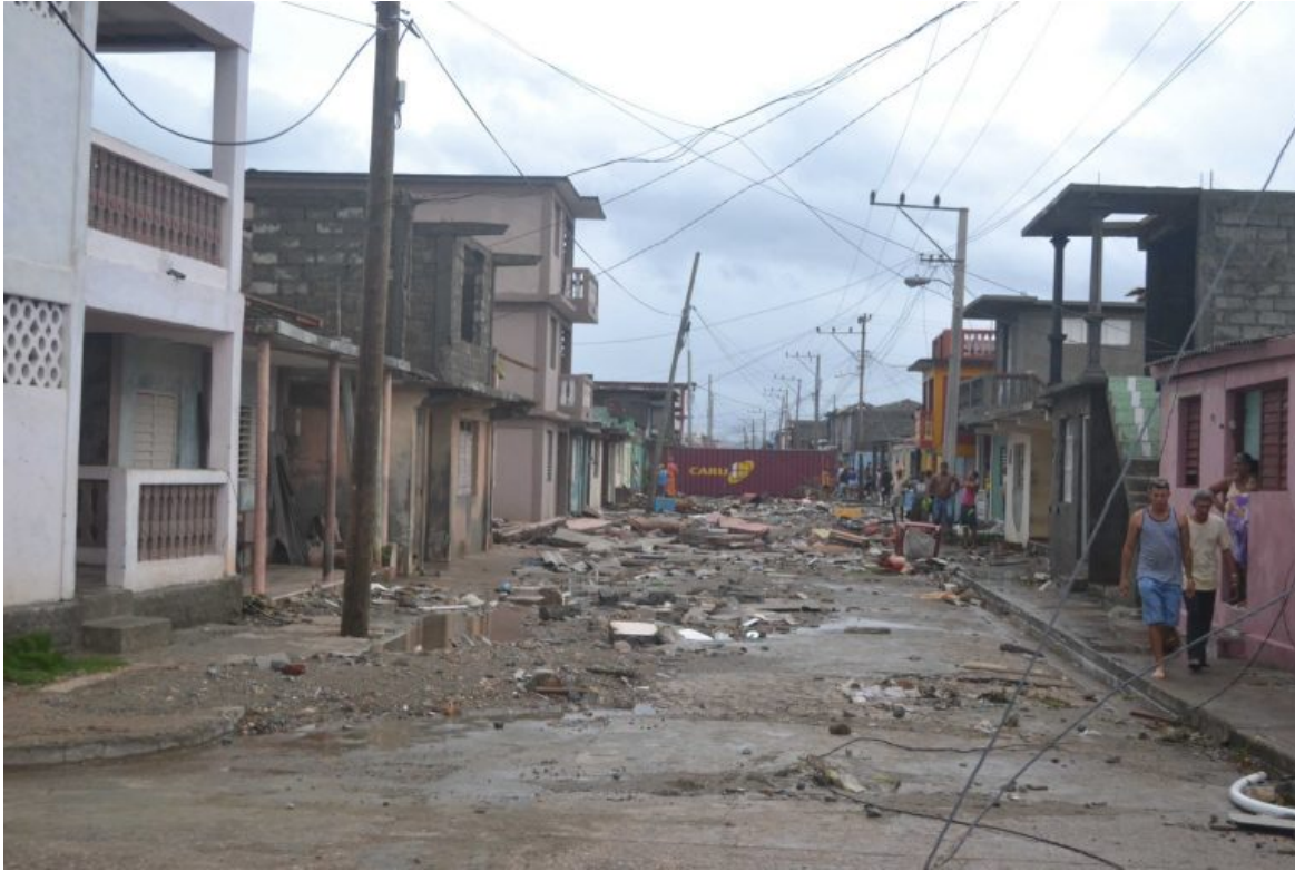
Zerstörte Straße in Baracoa am 5. Oktober (Quelle: Cubadebate )
