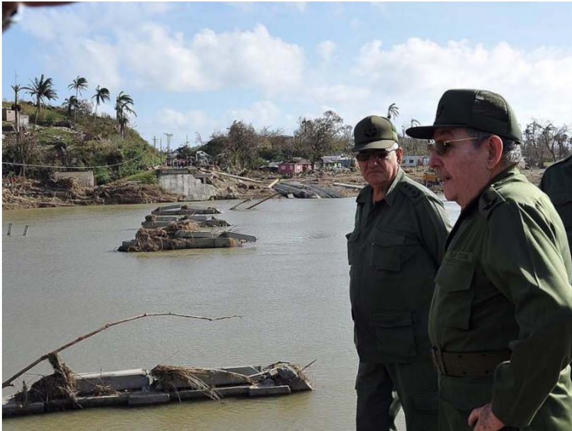
Raúl Castro (vorne) zusammen mit General Ramón Espinosa Martín vor der zerstörten Brücke am Río Toa (Quelle: Cubadebate )
