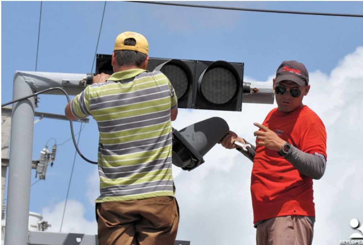
Auch Ampeln werden vorsorglich abmontiert, wie hier in der Provinz Las Tunas (Quelle: Cubadebate )
